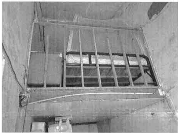
照片 10. 一层 A-B 交 5-6 轴区域搭建夹层
